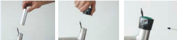
270 paveikslėlis. Slankiosios įvorės ir išorinės movos sumontavimas
